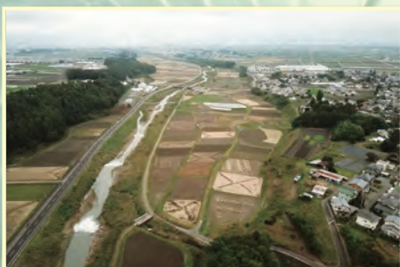
【区画が小さく不整形なほ場】
