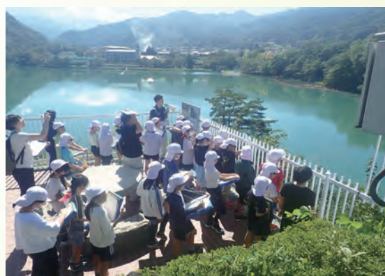
▲新たな見学コース（取水口がある高遠ダム）
